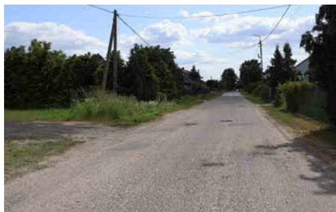
Droga w Strykowicach Górnych przed przebudową.
