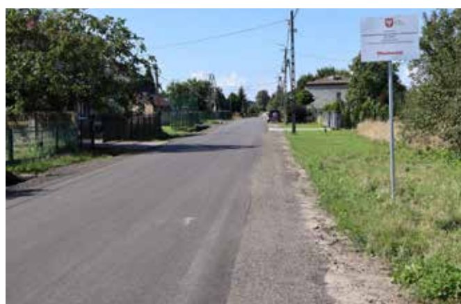
Droga w Strykowicach Górnych po przebudowie.
